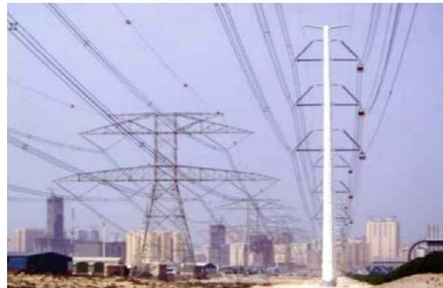
Рис. 5. Двухцепные линии 420 кВ – традиционная и компактная на многогранных DEWA Dubaj [7]
