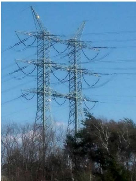
Рис. 10. Фрагмент трехцепной линии двойного напряжения вблизи SE Łagisza
