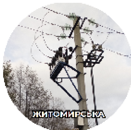
Аварійний вимикач мережі
