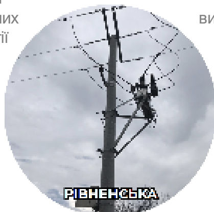
Секційний вимикач мережі
