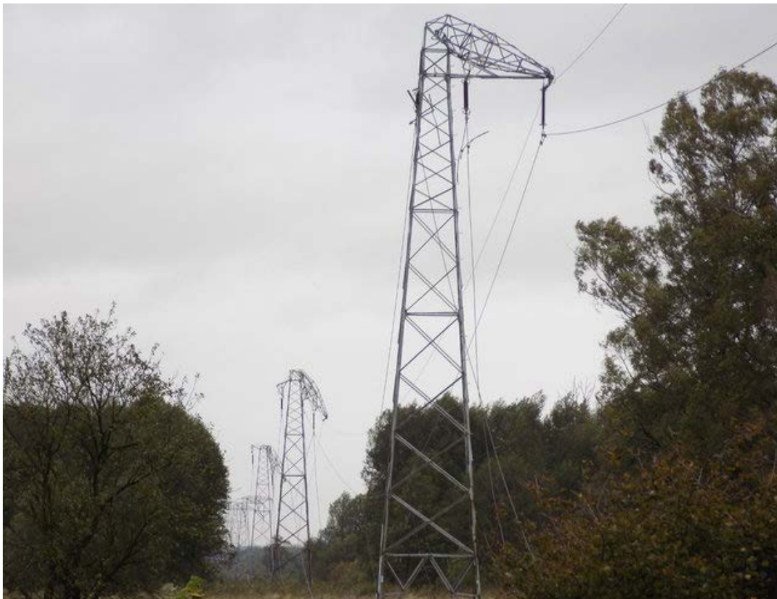
ФотоFot. 2 Знищена інфраструктура після урагану Ксаверій (Orkan Ksawery). Район розподільчих мереж Гожув (Gorzów) (матеріали групи Enea)
