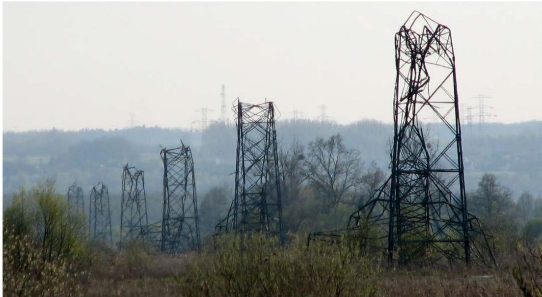
Фото. 1 Каскадне знищення проміжних опор 124÷129 на лінії 220 kV Morzyczyn-Police [1]
