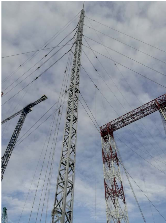
Фото 7 – Проміжна кутова опора 90^\circ 220 кВ з горизонтальним розміщенням проводів на випробувальному полігоні
