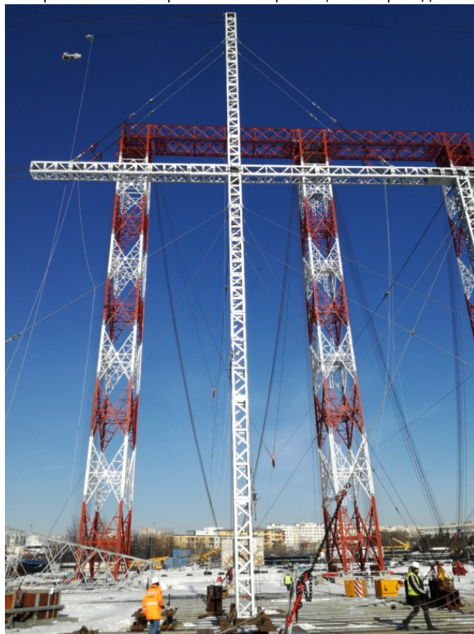
Фото 8 – Анкерно-кутова опора 150^\circ 220 кВ з горизонтальним розміщенням проводів на випробувальному полігоні, на задньому плані конструкції для випробування
